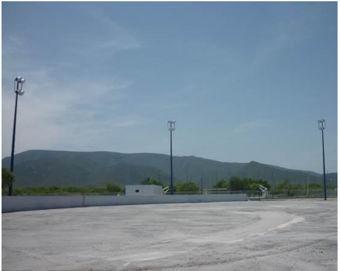
En la inspección física se detectó que no se ejecutó el concepto "Suministro e instalación por medios manuales de pasto artificial monofilamento para fútbol en exterior de 40 mm de altura".
