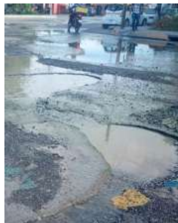
Drenaje en mal estado con brote de aguas negras, acumulación de basura por falta de frecuencia de paso de servicio de recolección y baches en avenida principal | Mayo-Junio 2025
