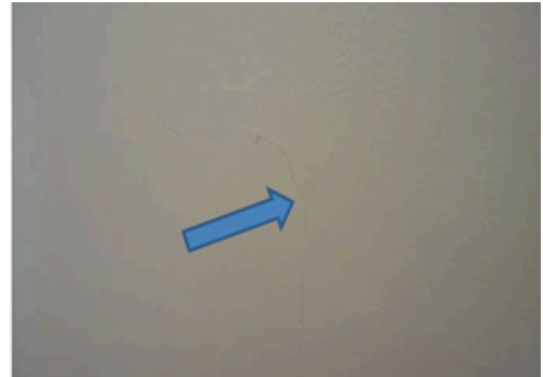
Grieta a 45 grados escalonada de piso a techo, en muro divisorio de sala de espera y archivo.
