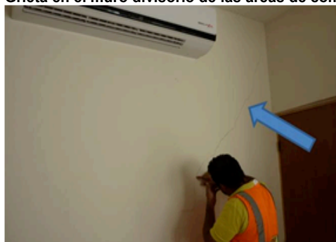
Grieta en el muro del area de descanso (imagen izquierda) y baños de hombres (imagen derecha), que ocasionó la rotura de dos azulejos colocados en el muro del baño de hombres.
