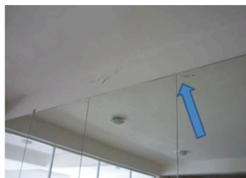
Grieta en el muro divisorio del área de tv (imagen izquierda) y área de ejercicio (imagen derecha), la cual ocasionó la rotura del espejo colocado sobre el muro que se localiza en el área de ejercicio.
