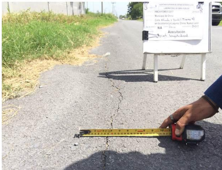
Agrietamiento longitudinal en el cadenamiento 0+011 de la calle Alfredo V. Bonfil.
