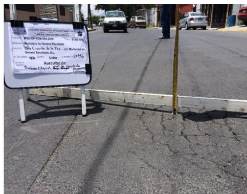
Falla No. 28.- Cadenamiento 0+196. Bacheo + Agrietamiento piel de cocodrilo.
