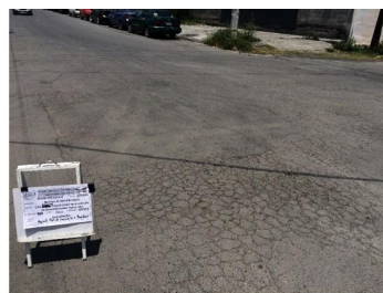
Falla No. 9. Cadenamiento 0+107. Agrietamiento piel de cocodrilo.
