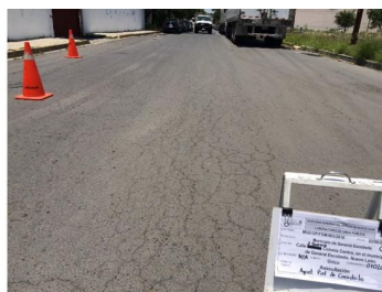
Falla No. 2.- Cadenamiento 0+020. Agrietamiento piel de cocodrilo.
