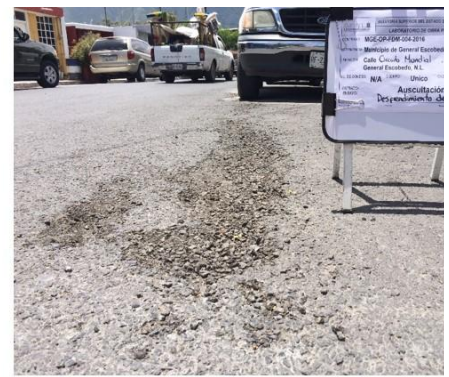
Falla No. 34. Cadenamiento 0+547. Desprendimiento de agregados.
