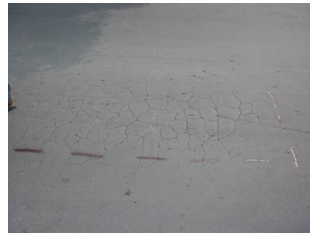
Deterioros en la carpeta asfáltica de la calle Circuito de la Paz.
