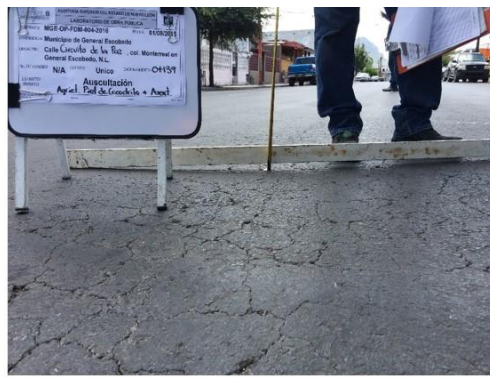
Falla No. 31.- Cadenamiento 0+139. Agrietamiento piel de cocodrilo + Asentamiento.
