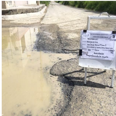
Deterioros en la calle Simón Bolívar: Desprendimiento de carpeta en el cadenamiento 0+186 (imagen izquierda); y asentamiento en el cadenamiento 0+121 (imagen derecha).
