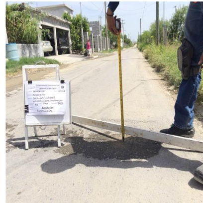
Deterioros en la calle Simón Bolívar: Desprendimiento de carpeta en el cadenamiento 0+186 (imagen izquierda); y asentamiento en el cadenamiento 0+121 (imagen derecha).
