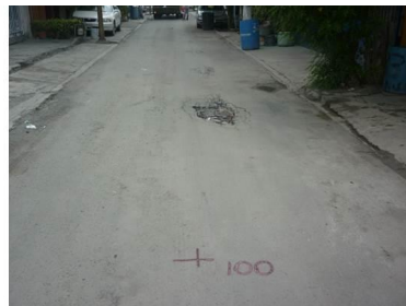
Deterioros en la carpeta asfáltica de la calle Del Arte.
