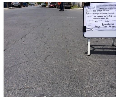
Falla No. 19. Cadenamiento 0+175. Agrietamiento tipo mar.
