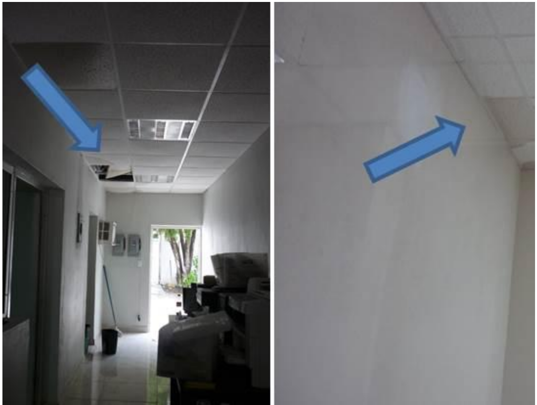
Filtraciones de agua en el pasillo de las oficinas de Agricultura (imagen izquierda), en la oficinas de Desarrollo Social (imagen central) y en el pasillo general (imagen derecha).
