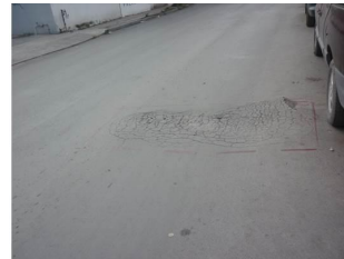
Deterioros en la carpeta asfáltica de la calle Circuito de la Paz.
